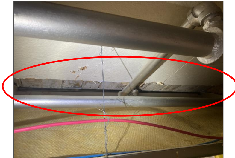
Photo 8 – Taches grisâtres sur le platelage en bois, salle à dîner
